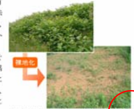
有害な植生の侵入による堤防の裸地化
