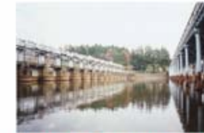
猪苗代湖水面水位調節施設 十六橋水門(明治13年) ※小石ヶ水門の完成により、現在は洪水時のみ開扉
