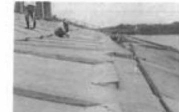
53年宮城県沖地震による護岸の被災状況【宮城県岩沼市】
