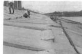
53年宮城県沖地震による護岸の被災状況【宮城県岩沼市】
