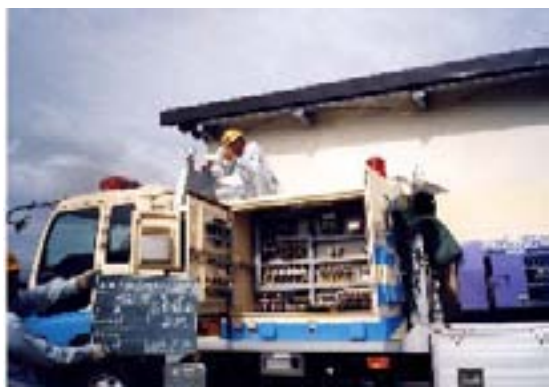
排水ポンプ車点検の様子
