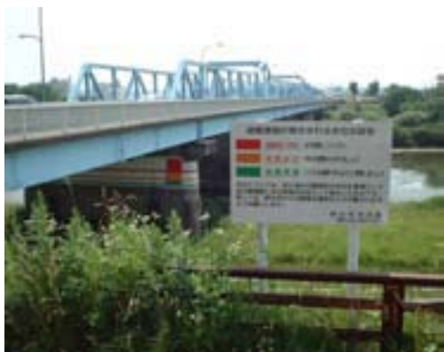
国道49号金山橋(郡山市)への避難情報の表示
