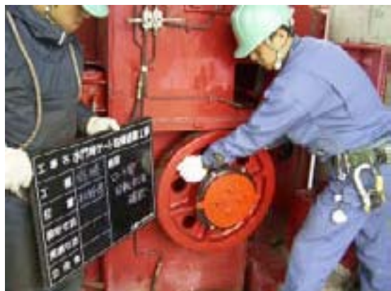
ゲート設備の維持補修
