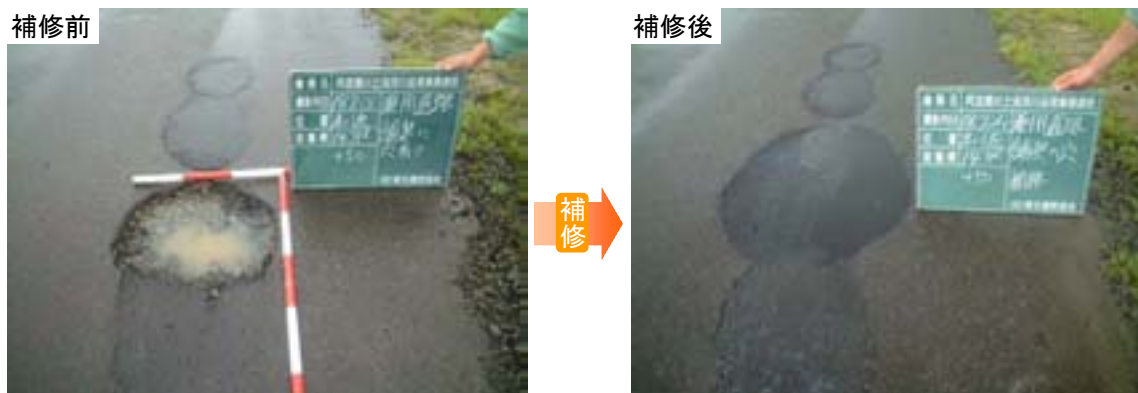
堤防天端舗装の補修
