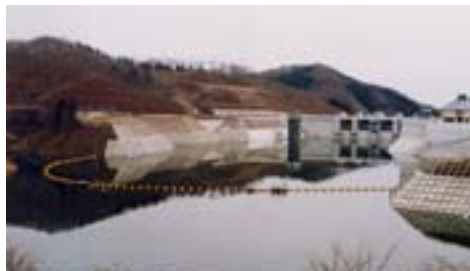
三春ダム 流木止施設
