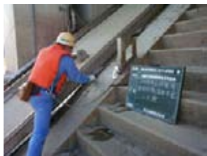
係船レールの点検状況
