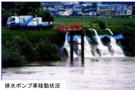
愛宕川排水機場
