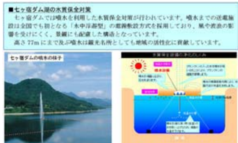
七ヶ宿ダムの水質保全設備
