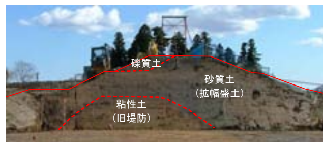
堤防開削断面 (阿武隈川下流 右岸36k付近)
