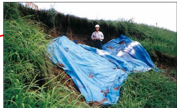
<昭和61年洪水> 漏水状況
