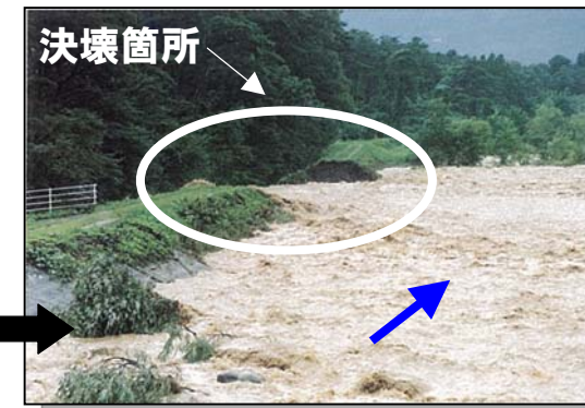
<平成10年洪水> 阿武隈川左岸支川荒川における堤防の決壊
