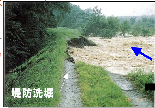
<平成10年洪水> 阿武隈川左岸支川荒川における堤防の決壊
