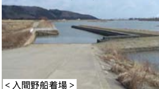
土砂堆積による機能障害の解消のため 導流堤を設置(H18.3)
