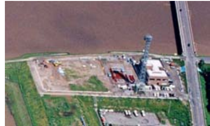
防災ステーション（郡山市）
