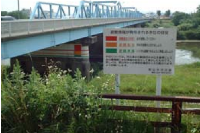
国道49号金山橋(郡山市)への避難情報の表示
