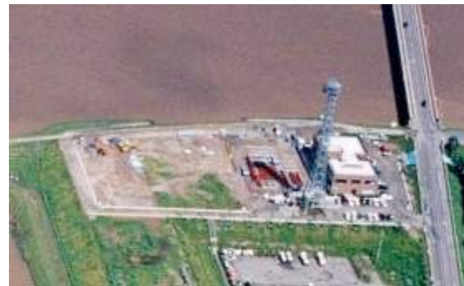
防災ステーション（郡山市）
