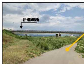
管理用通路 （散策路）
