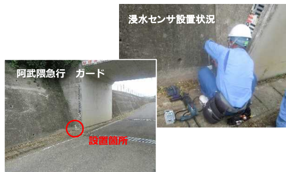
◀▲浸水常襲箇所に浸水センサ設置
