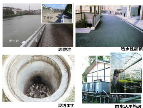
雨水貯留浸透施設の例
