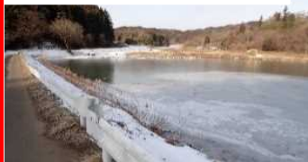
農業用ため池の治水整備(白河市)
