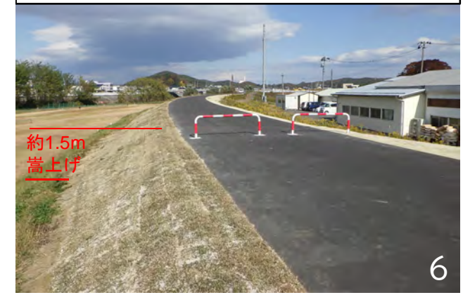
【右岸】堤防嵩上げ完了(令和2年5月)
