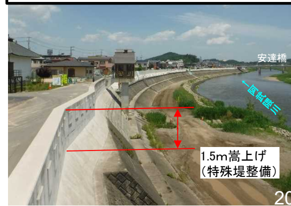
左岸地区 築堤工事完了状況
