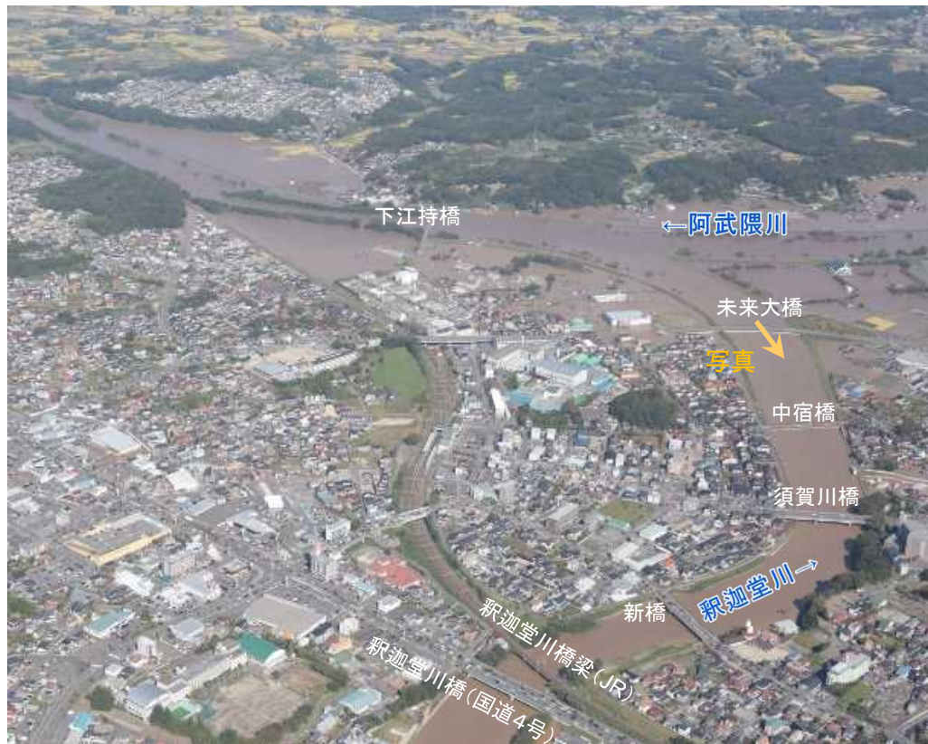
令和元年10月13日13時頃撮影(国土地理院)
