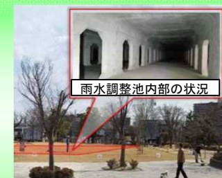
下水道事業による雨水貯留施設の例(郡山市)
