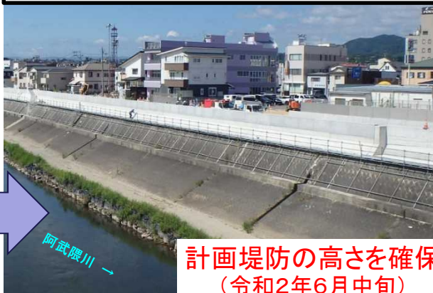
嵩上げ対策状況
