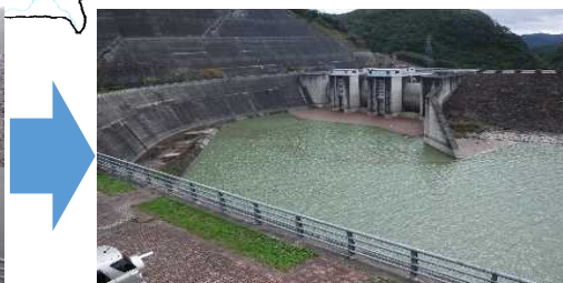
10月14日9:00時点の貯水位状況
