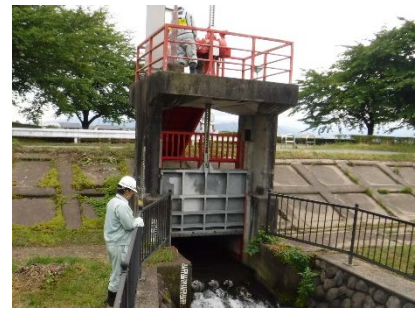
樋管点検状況
