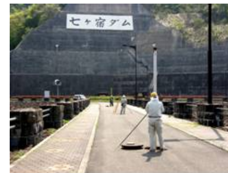
堤体変位測量
