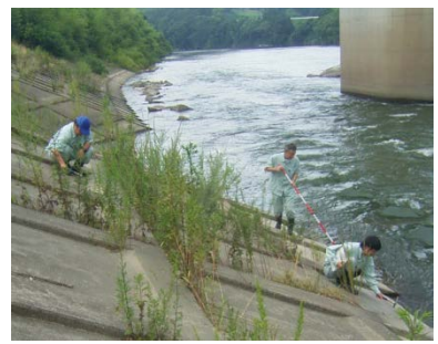
護岸点検状況
