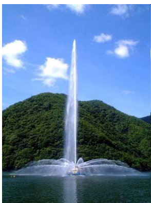
高さ77mにまで及ぶ ダム湖の噴水施設
