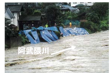
●平成10年8月洪水の被害状況
