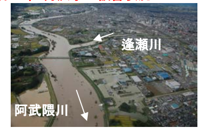
●平成23年9月洪水の被害状況
