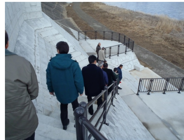
本宮地区まちづくり懇談会による現地視察の状況
