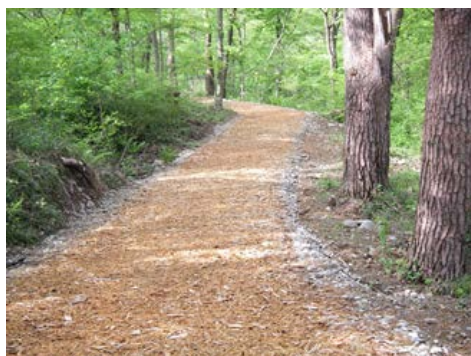
散策路へのウッドチップ敷設状況
