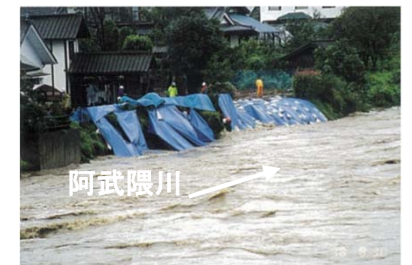
河岸崩壊の拡大を防ぐシート張り（福島県福島市）
