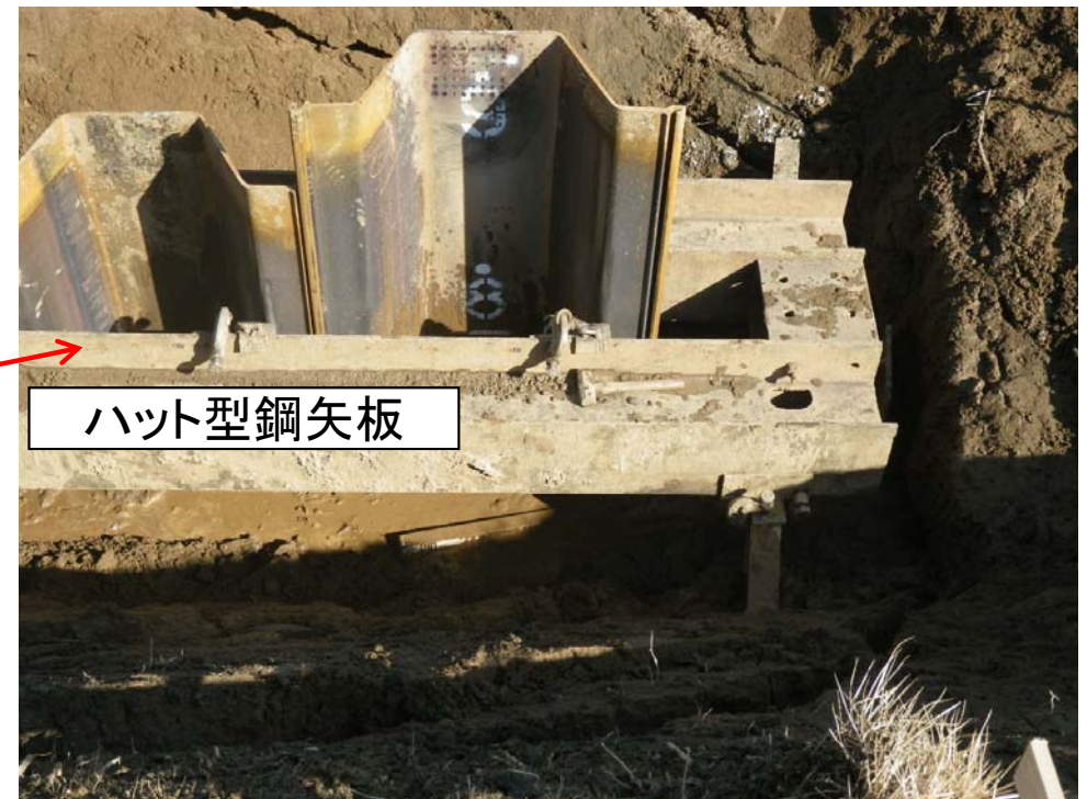
縮減策 「阿武隈川下流右岸小山地区堤防整備工事」の事例
