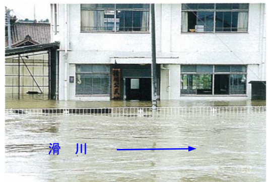
洪水によって冠水した滑川公民館 (福島県須賀川市)
