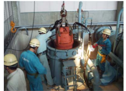
排水機場点検の様子
