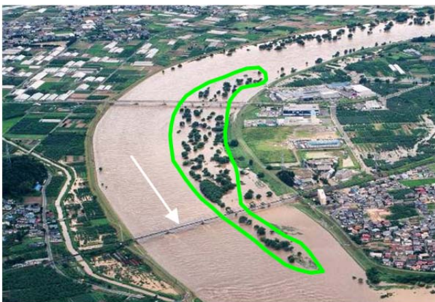
洪水時において流下阻害となる樹木群の例（福島県伊達市）
