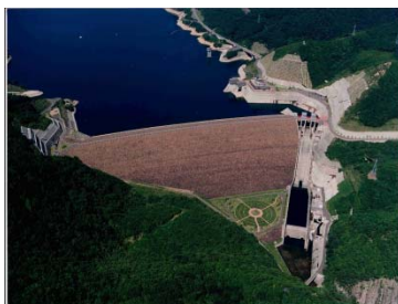
七ヶ宿ダム(H3完成)
