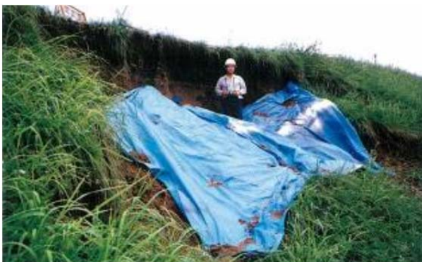
昭和 61 年 8 月洪水法崩被害の状況 (岩沼市 押分地区)
