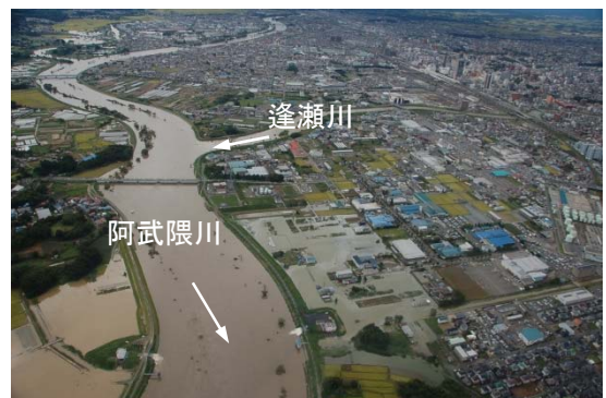
市街地の浸水状況（福島県郡山市）
