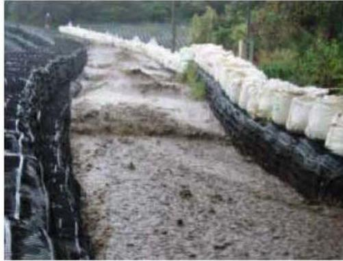
大型土嚢を配置した仮導流堤
