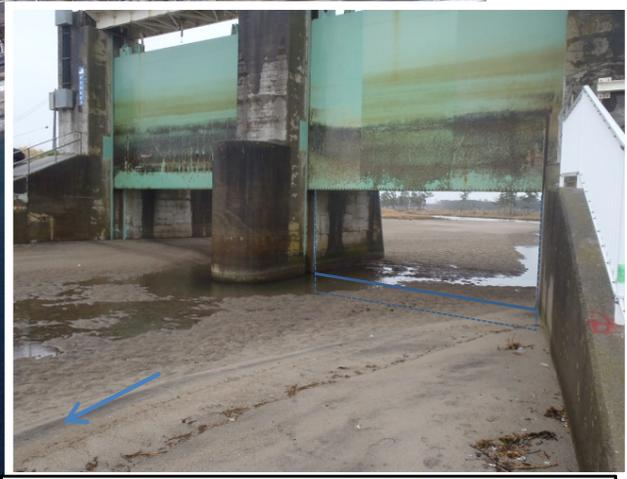
川側より新浜水門を望む (H26.4.21撮影) ※堆砂除去前の状況
