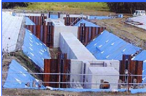
プレキャスト構造（弾性接合方式） 【NETIS : HK-030028-V】
