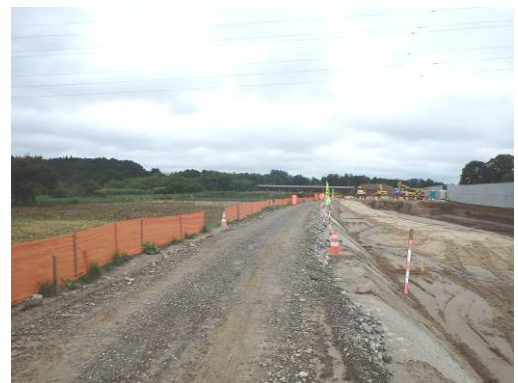
⑥現在のトロミ地区工事状況
