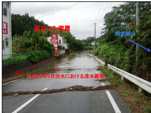
①平田高田地区における道路冠水状況と孤立する家屋
