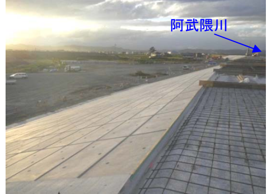
川裏被覆ブロック設置状況
