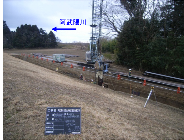
平成25年度 整備実施状況(左岸2.3km付近)
