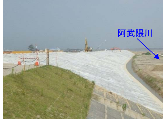
川表被覆ブロック設置状況
