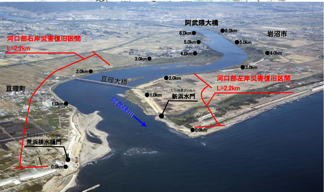
復旧状況斜め写真(平成25年10月14日撮影)
