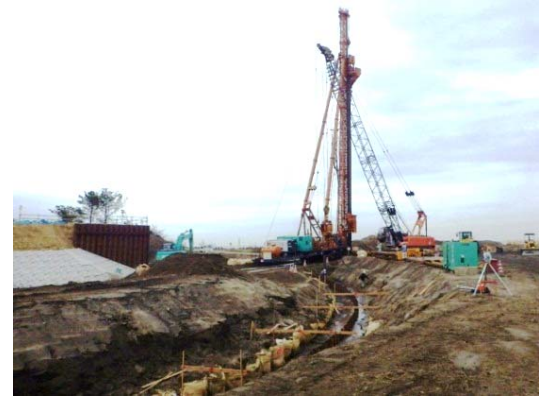
地盤改良状況
