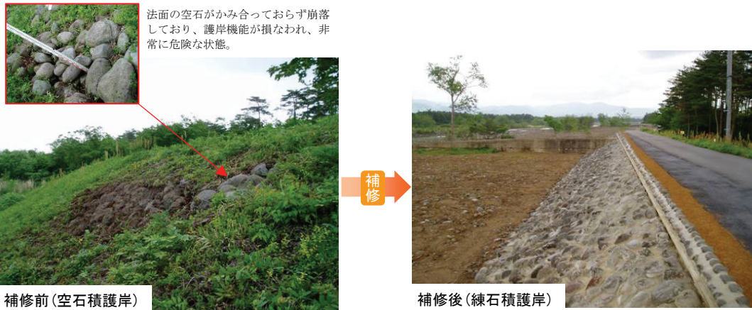
空石積護岸の補修(支川荒川)
