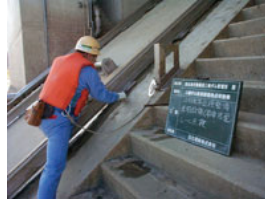
係船レールの点検状況
