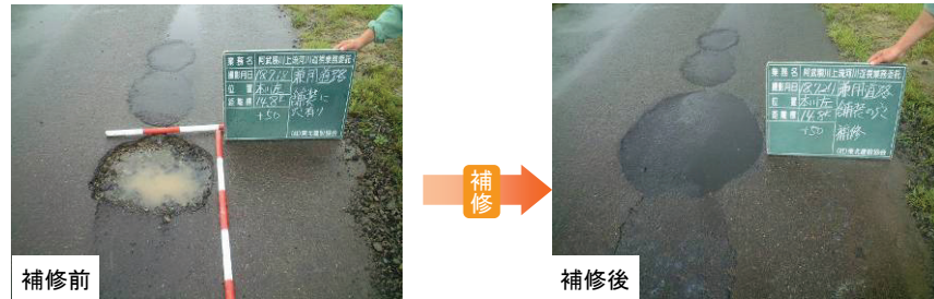
堤防天端舗装の補修
