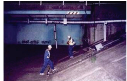
地震後の護岸点検状況 (国道6号阿武隈橋、平成15年5月26日)
