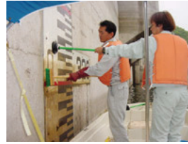
量水板の清掃状況
