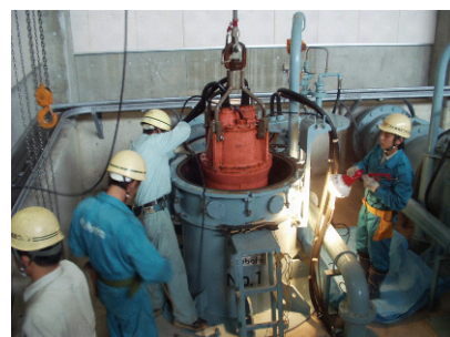
排水機場点検の様子
