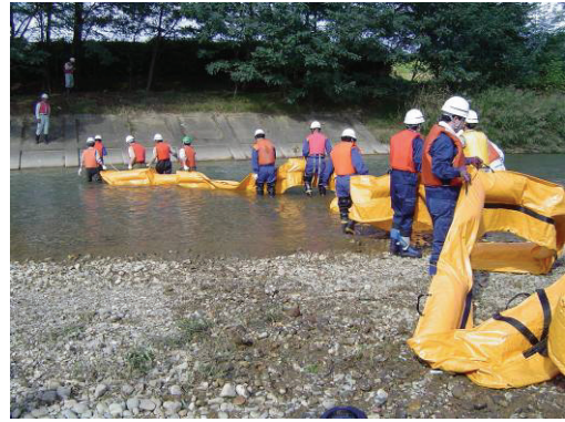
オイルフェンス設置訓練実施状況
