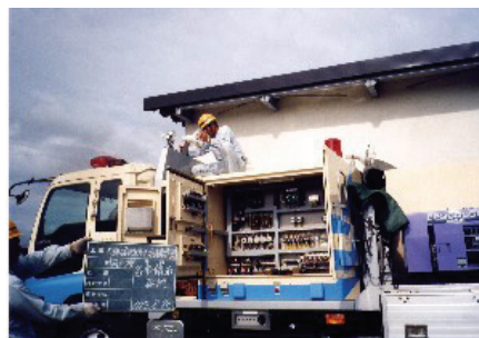
排水ポンプ車点検の様子
