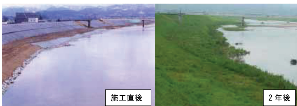
平成の大改修で行われた多自然川づくりの例(河口より60km付近)
