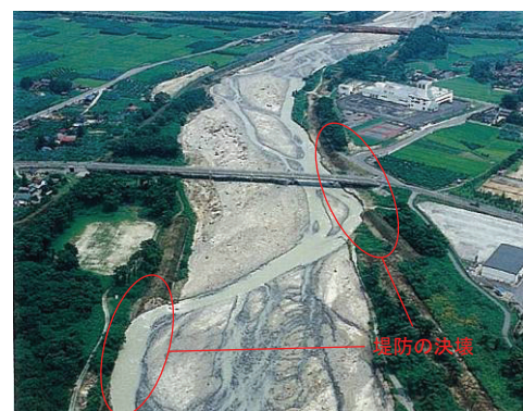
低水路の蛇行による堤防決壊 平成元年8月洪水 支川荒川
