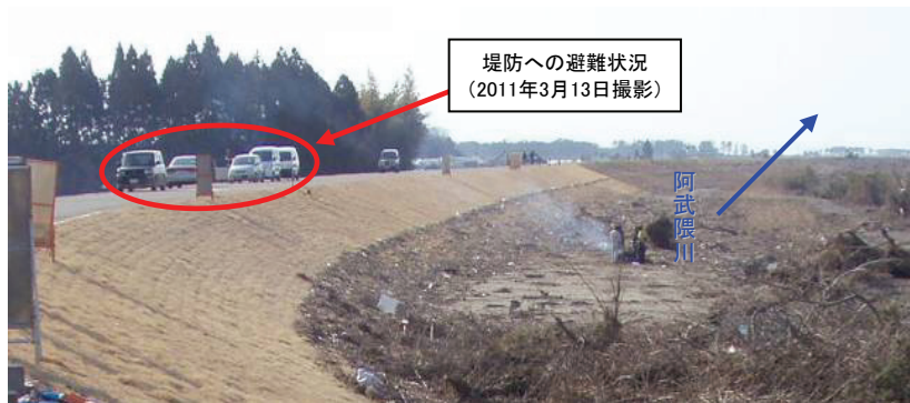
寺島堤防(岩沼市寺島地区)
