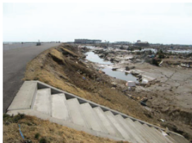
現地状況：① (河口から右岸 0.2k 付近、 亘理町荒浜地先)
