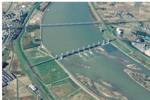
図 3-19 阿武隈大堰 (S57 完成)
