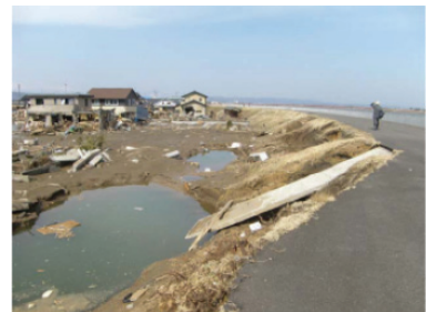
現地状況：③ (河口から右岸 0.4k 付近、 亘理町荒浜地先)
