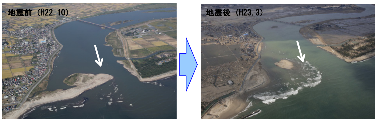
東北地方太平洋沖地震前後の阿武隈川河口部の状況
