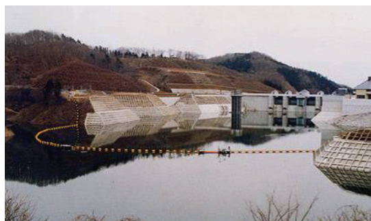
三春ダム 流木止施設
