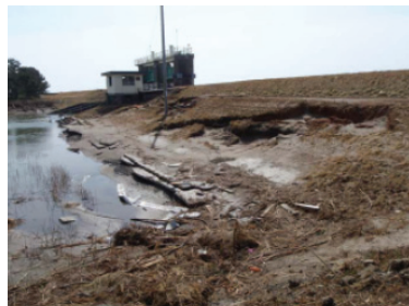
現地状況：② (河口から左岸 0.5k 付近、 岩沼市寺島地先)
