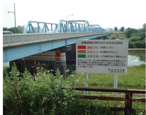
かなやま 国道49号金山橋(郡山市)への 避難情報の表示
