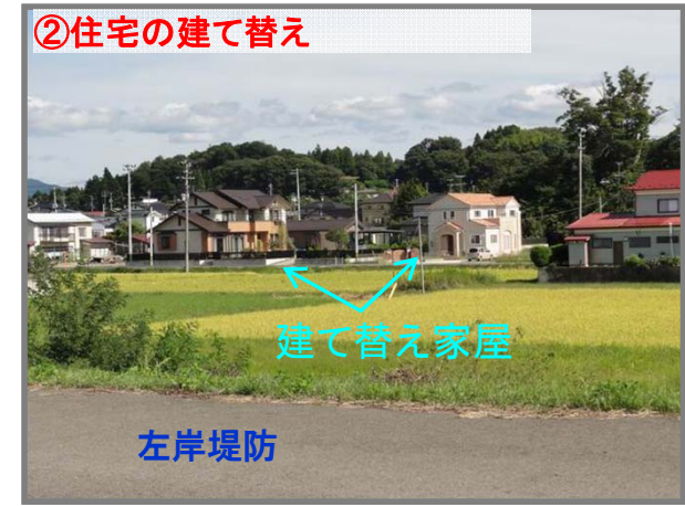
②住宅の建て替え 堤防内で住宅の新築、改築が促進
