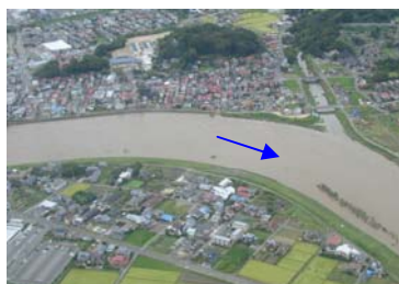
本宮地区築堤事業 (実施中)
