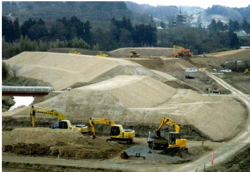
阿武隈川左岸油井地区築堤工事
