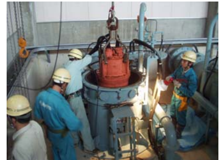
排水機場点検の様子
