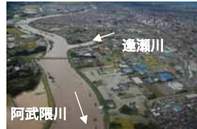
家屋及び農地浸水被害が発生した(福島県郡山市)
