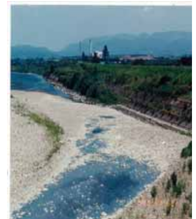
河床が露出した大正橋下流(福島県伊達市)
