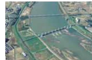
図 3-21 阿武隈大堰(S57完成)
