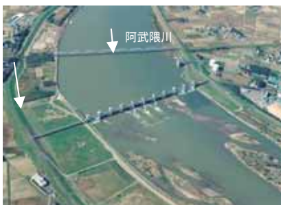
阿武隈大堰 (S57完成)
