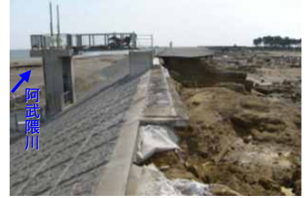
阿武隈川右岸0.0k付近 亶理町荒浜地先 津波により堤防決壊
