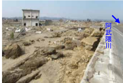
阿武隈川右岸-0.1k付近 亶理町荒浜地先 津波により堤防決壊
