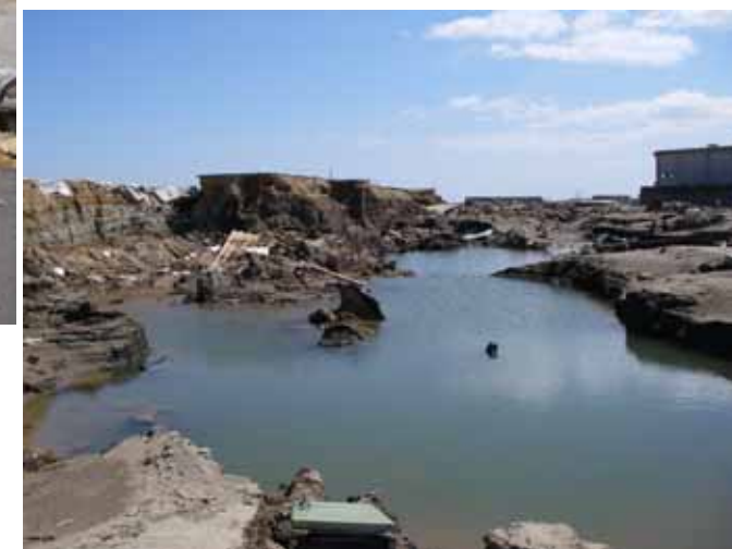
阿武隈川右岸（荒浜地区） 津波による堤防決壊
