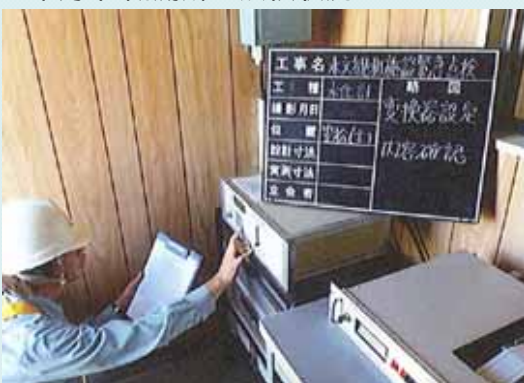
笠松水位観測所の点検状況
