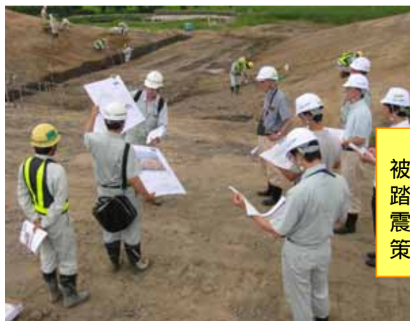
堤防被災の原因調査状況
