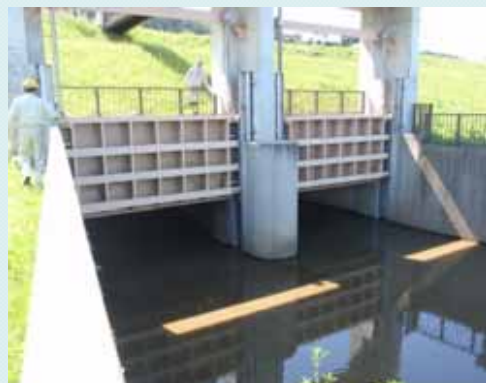
出水期前点検の様子 (鳩原排水樋管)
