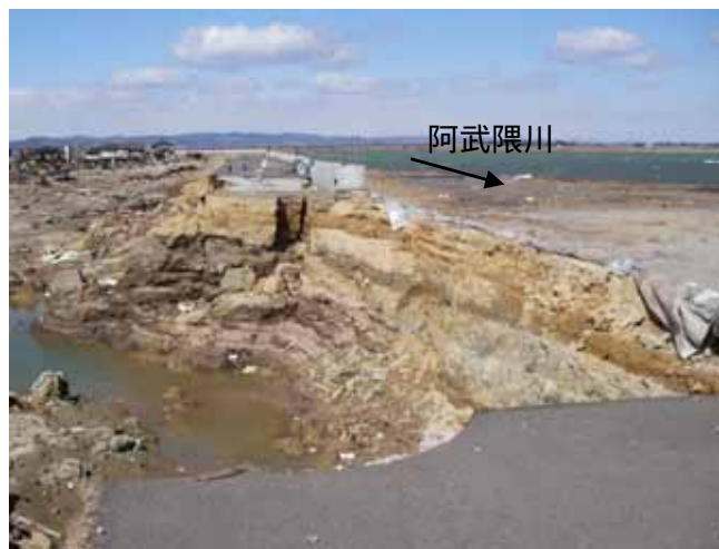
阿武隈川右岸（荒浜地区） 津波による堤防決壊
