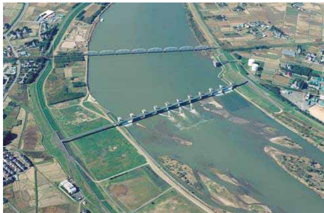
阿武隈大堰 (S57完成)
