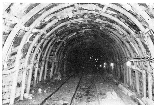
写-3-4-13 関(西口)坑口附近導坑支保工
