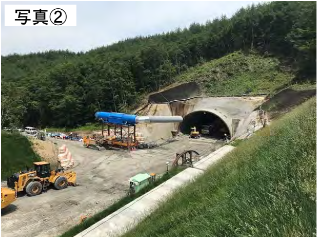
▲ (仮称)久慈長内トンネルの施工状況
