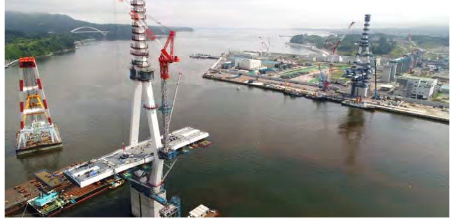
▲(仮称)気仙沼湾横断橋の上部工施工状況(海上部)
