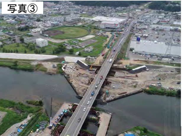
▲ 久慈大橋下部工の施工状況
