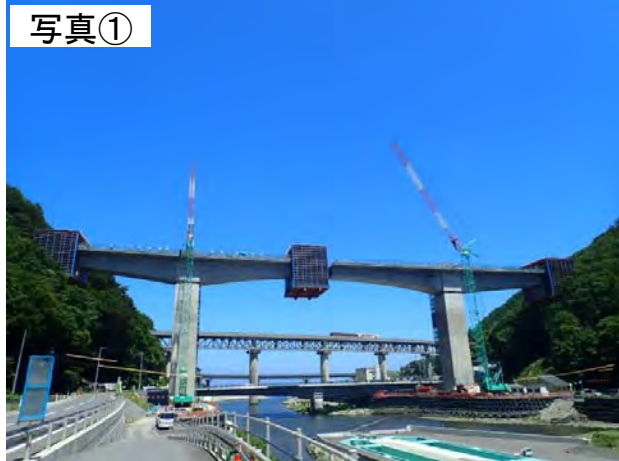
▲ (仮称)新安家大橋上部工の施工状況
