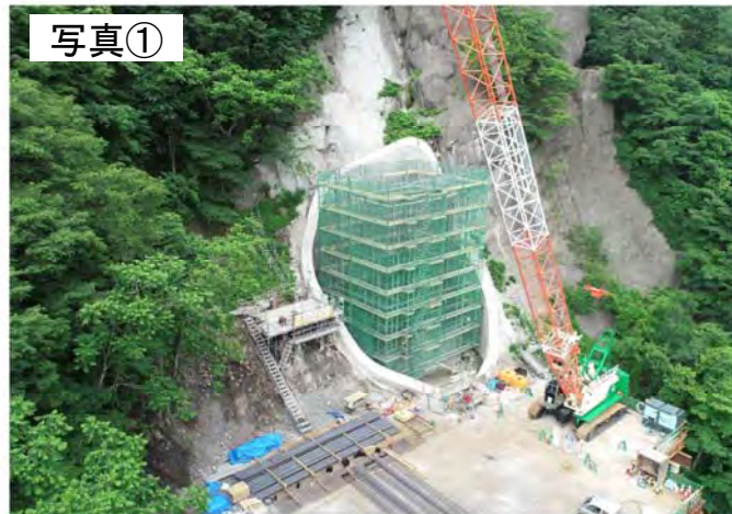
▲(仮称)新思惟大橋下部工の施工状況
