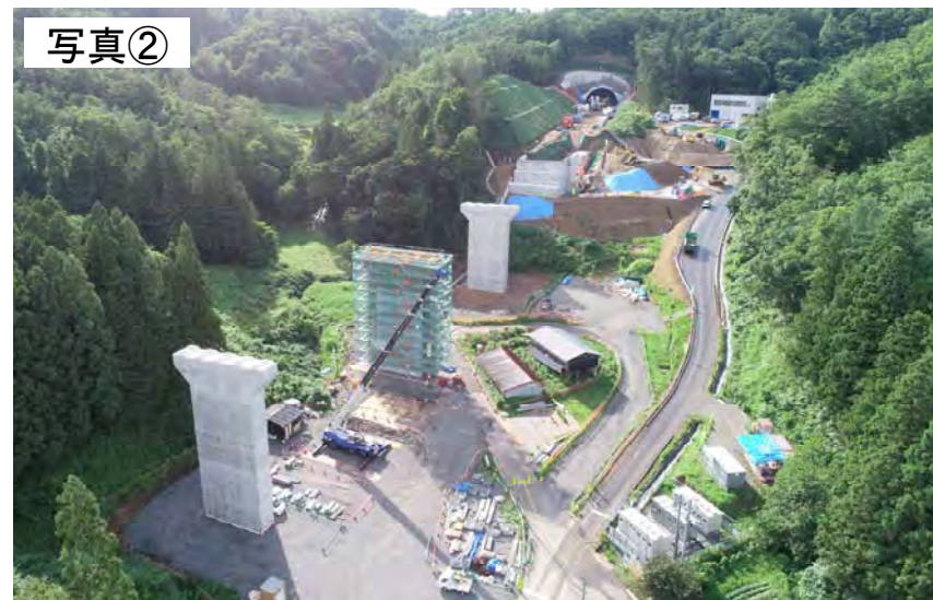
▲（仮称）掛田橋下部工の施工状況
