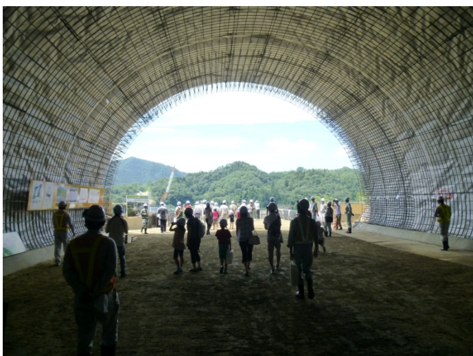
▲境ノ目トンネルへ移動し、坑内を歩いて月館高架橋へ向かいます。
