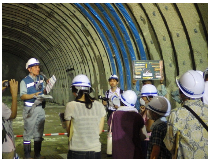
▲金弁蔵トンネル坑内で施工者からトンネルの掘削方法について説明しました。
