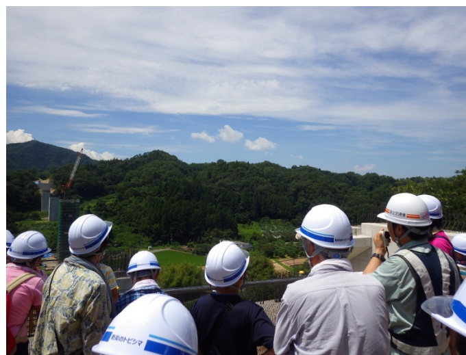
▲境ノ目トンネル坑口から施工中の月館高架橋が一望できました。
