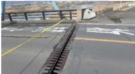
A 1 伸縮装置の破損
