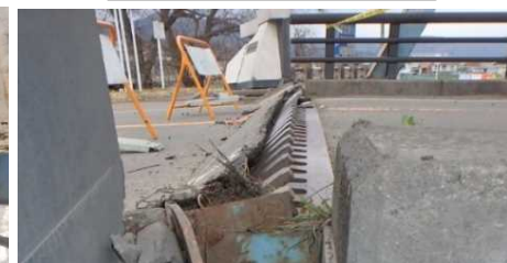
A 2 伸縮装置の破損
