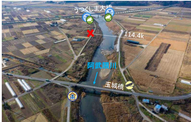
○危険箇所付近の斜め写真(114.4k付近)
