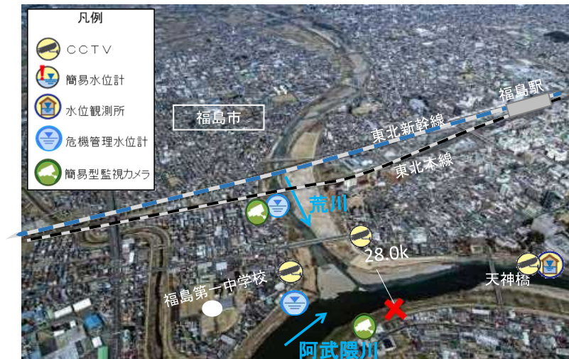
○危険箇所付近の斜め写真(28.0k付近)
