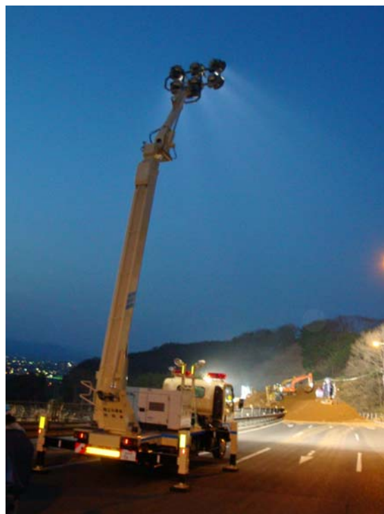
東日本大震災での照明車稼働状況 （福島県福島市伏拝地区）
