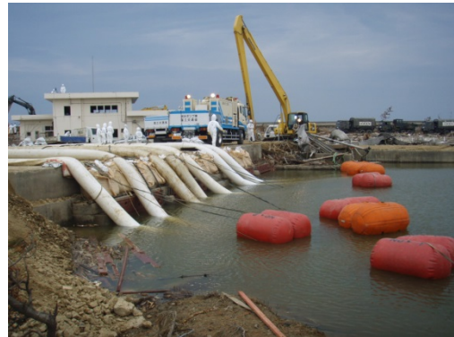
東日本大震災での排水ポンプ設置状況 （福島県沿岸地域）
