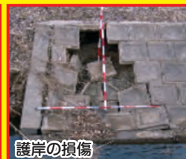
護岸の損傷
