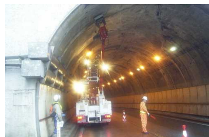
写真2-2 トンネル点検状況
