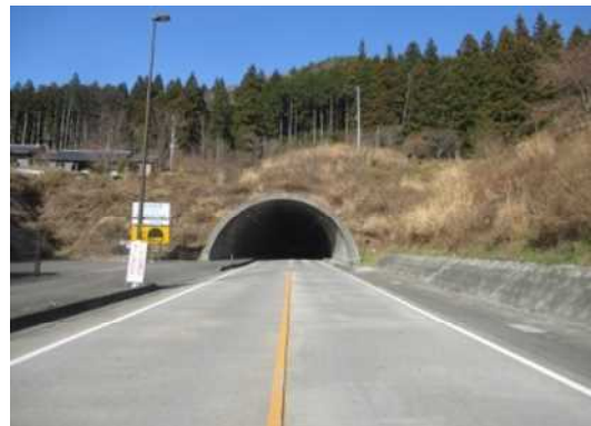
写真4-16 【全景】 いわき水石トンネル
