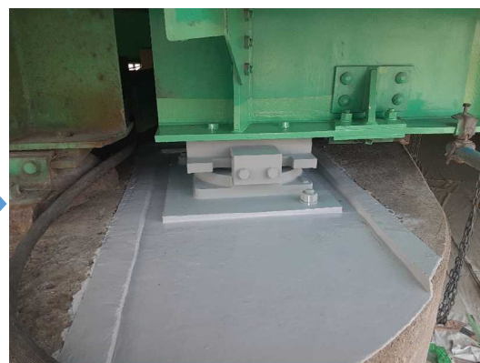
写真4-3 【対策】支承交換
