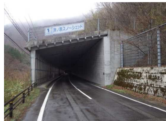
写真4-22 【全景】芦ノ原スノーシェッド
