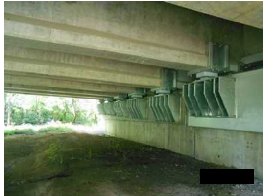
写真4-15 【対策】 支承の取替え
