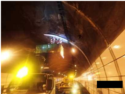
写真4-20 【損傷】漏水
