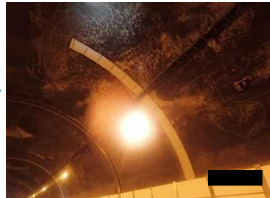
写真4-21 【対策】導水樋設置
