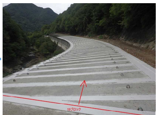
写真4-24 【対策】上部工の防水
