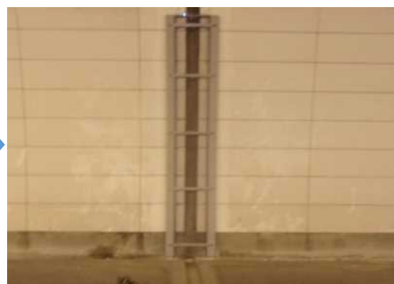
写真4-18 【対策】導水樋設置
