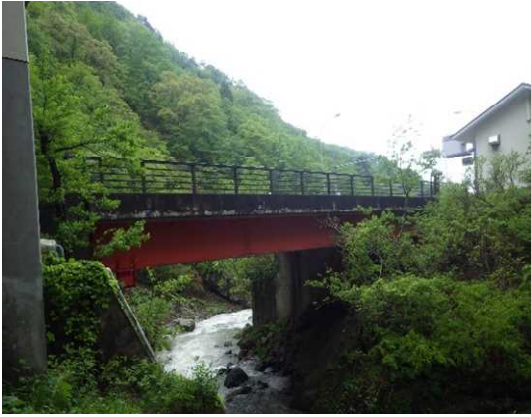
写真 4-7 【全景】飯森沢橋
