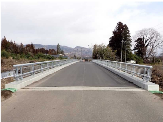
写真 4-12 【対策】 高欄・地覆・舗装の更新
