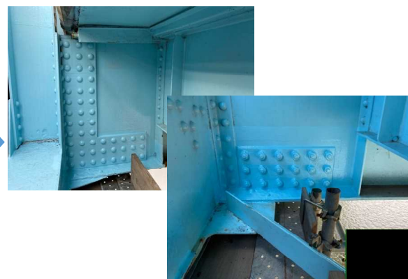
写真4-6 【対策】主桁のあて板補修
