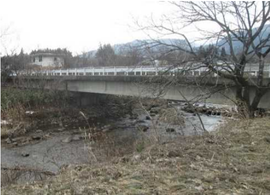
写真 4-10 【全景】日照沢橋
