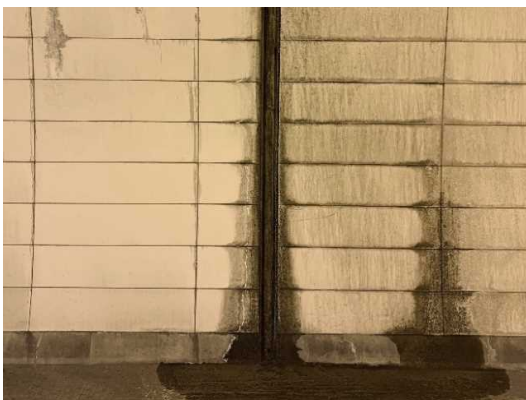
写真4-17 【損傷】漏水
