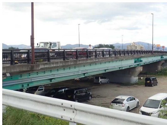
写真4-1 【全景】松川橋（上り線）
