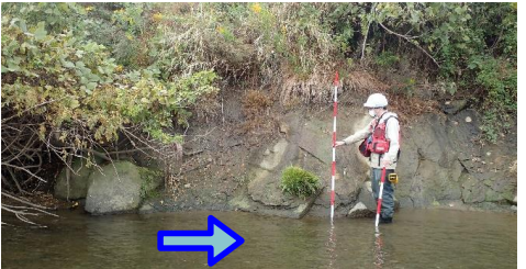
①左岸側に分布する溶結凝灰岩の様子(94k付近)
