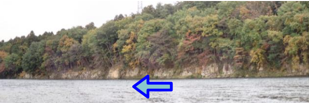
②右岸側に分布する溶結凝灰岩の崖(93.8k付近)
