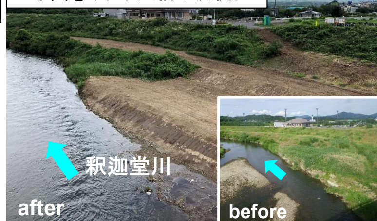
写真①(未来大橋下流側)
