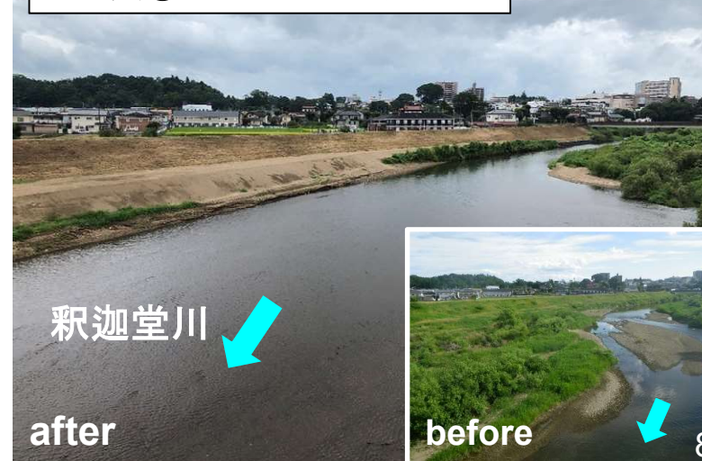
写真②(未来大橋上流側)
