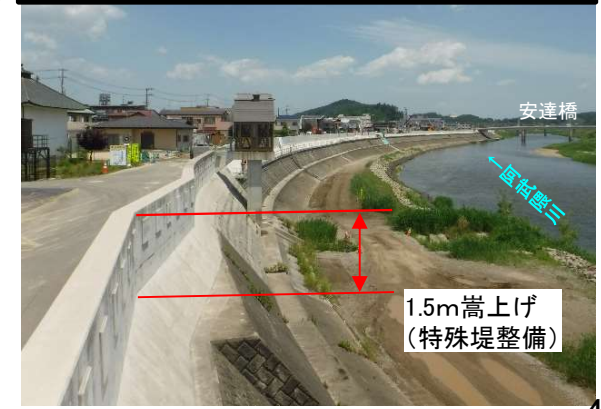
左岸地区 築堤工事完了状況
