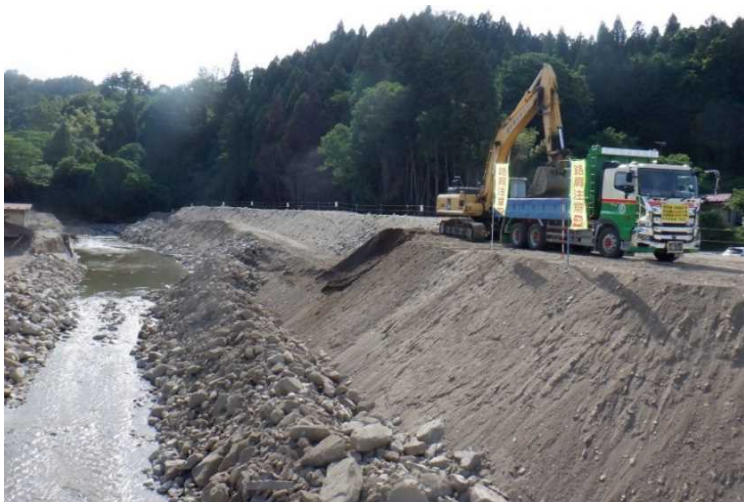
河道掘削の状況(河川)
