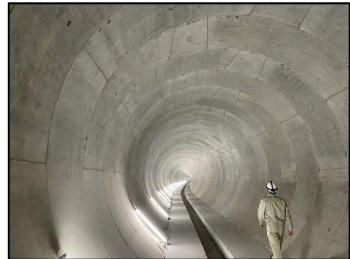
雨水貯留管内部 (仕上がり内径φ5,250mm)
