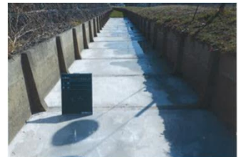
底張りコンクリート
