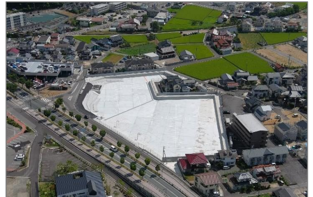
三次市による雨水貯留施設の整備
