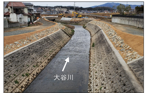
広島県による支川の改修
