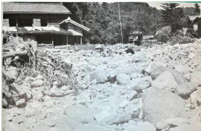
「羽越水害」の被害写真
