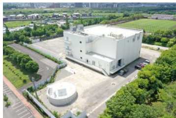
雨水ポンプ場
