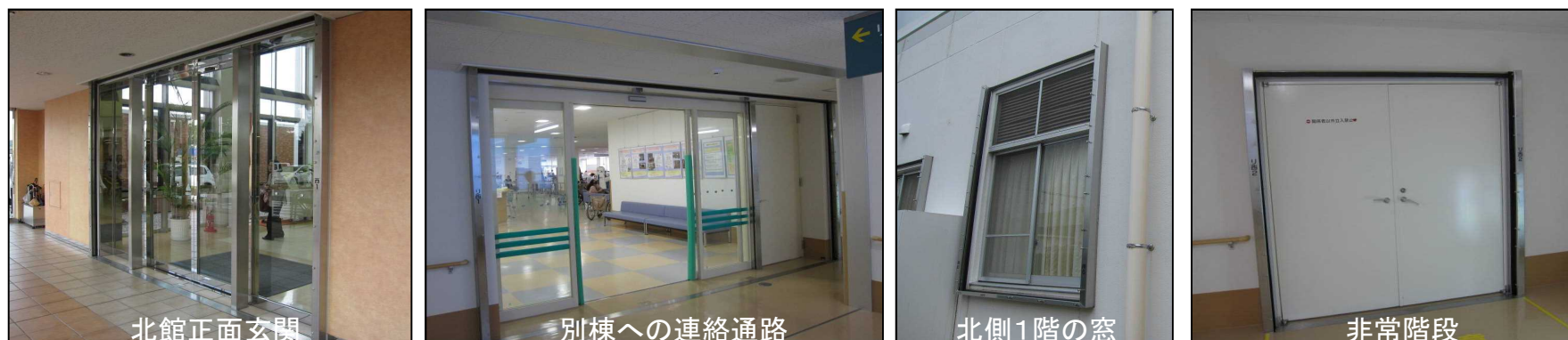
止水板のための角落しとの設置
