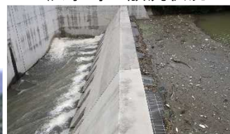
洪水時の放流状況
