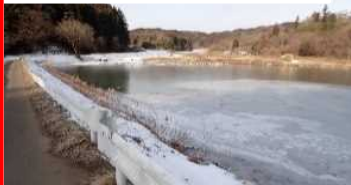
農業用ため池の治水整備(白河市)
