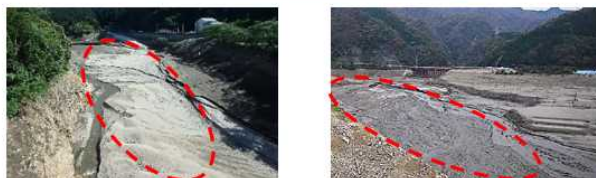
ダム貯水池内の堆砂の状況
