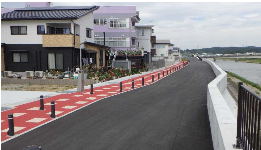
↑ 整備された阿武隈川左岸堤防
