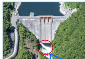
放流設備からの放流状況
