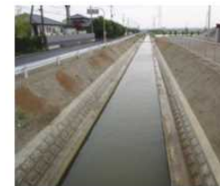
排水路の整備
