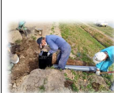
排水口の整備
