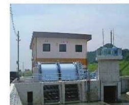
排水機場の整備
