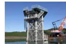
取水設備の整備
