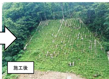
写真：簡易法枠吹付け工
