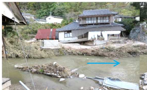
被災状況：広瀬川（川俣町）
