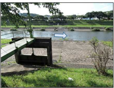
⑲阿武隈1号樋門
