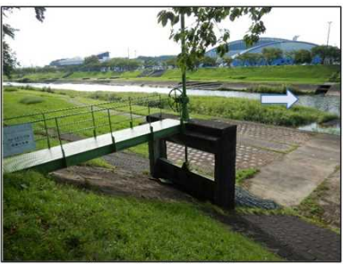
⑯西川新橋上流右岸樋門
