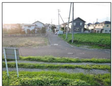
④中宿第2樋管堤内地側 (下水道暗渠)
