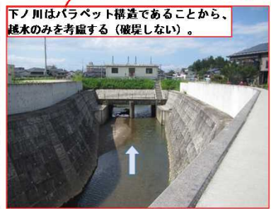
⑤須賀川樋門
