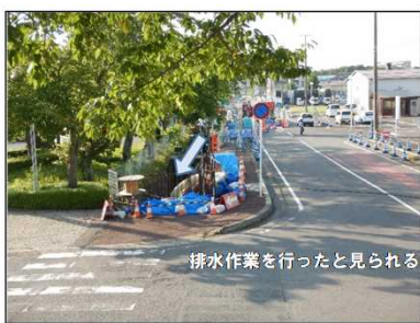
⑰阿武隈1号樋門堤内地側の水路 (笹平川) 排水作業を行ったと見られる
