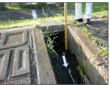
⑲阿武隈1号樋門左岸水路
