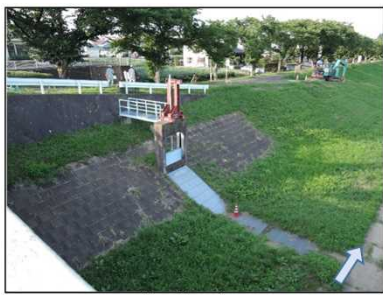
⑮阿武隈2号樋門
