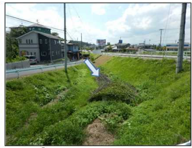
②下江持樋管堤内地側の水路
