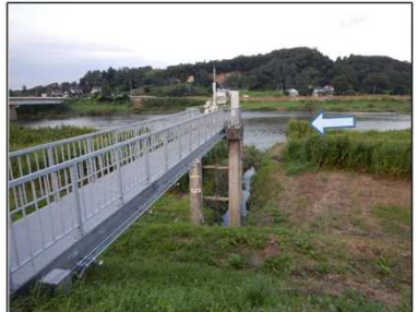
③昭和町樋
