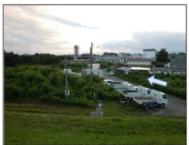
③昭和町樋管堤内地側の水路
