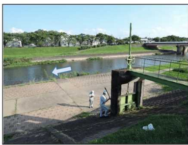
⑲阿武隈2号樋門
