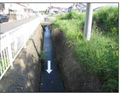
⑲阿武隈1号樋門堤内地側の水路
