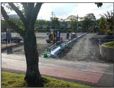
⑲阿武隈2号樋門堤内地側の水路
