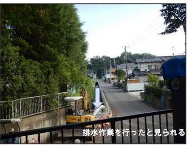
⑯西川新橋上流右岸樋門堤内地側の水路 排水作業を行ったと見られる
