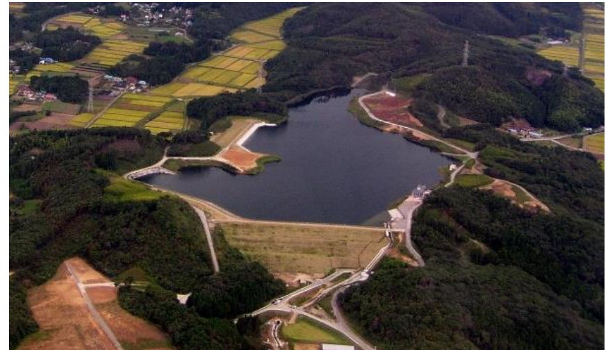
○山ノ入ダム (阿武隈川水系 山ノ入川) 完成年度 : 平成16年 目的 : 利水ダム かんがい面積 : 553.0ha
