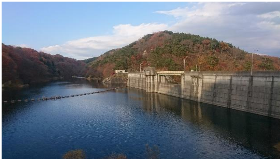
○岳ダム (阿武隈川水系 原瀬川) 完成年度 : 昭和54年 目的 : 利水ダム かんがい面積 : 703.5ha
