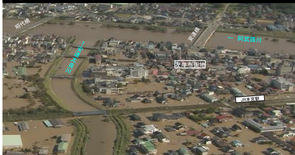
大規模洪水により浸水被害が発生(令和元年東日本台風)
