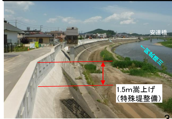
左岸地区 築堤工事完了状況
