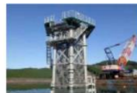
取水設備の整備
