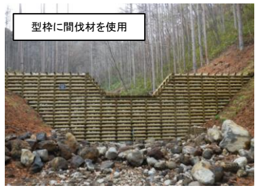
写真：(左)鋼製スリット谷止工(福島署管内)、(右)木製あぜ倉式谷止工(福島署管内)
