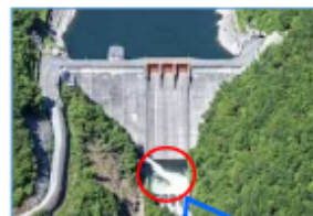
放流設備からの放流状況
