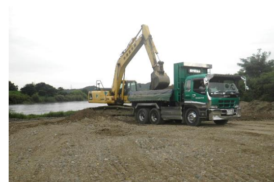
ダンプへの積み込み
