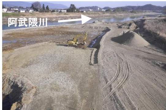
バックホウによる掘削
