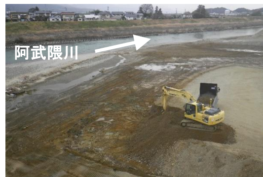
バックホウによる掘削
