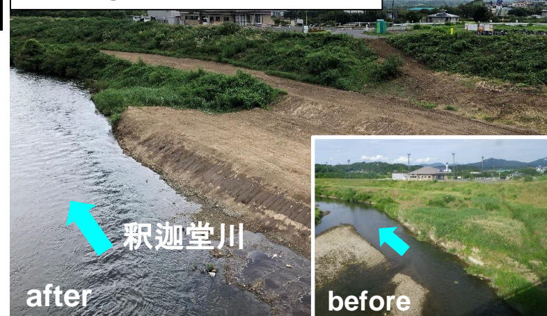
写真①(未来大橋下流側)
