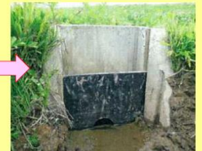
水戸板設置状況
