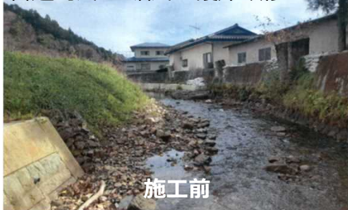
普通河川 金堀川 護岸改修
